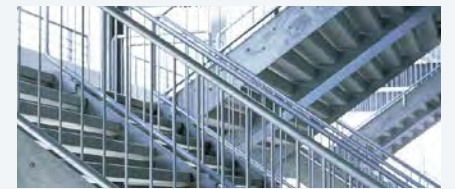
▲溶融亜鉛めっき処理を施した施工例
