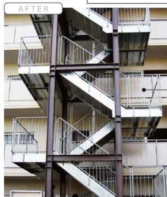
既存の鉄骨を活かし、階段と手すりを取替えた例
