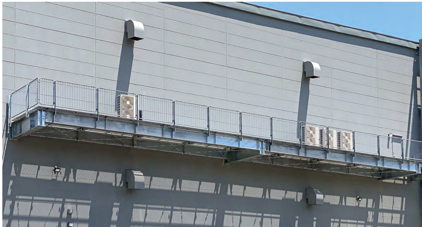
Ⅰ 施工事例 某所物流センター
