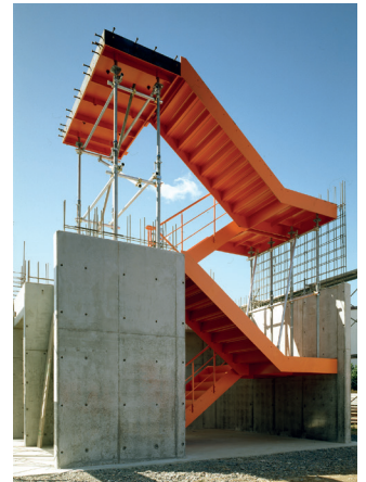
RC建筑的钢制楼梯
