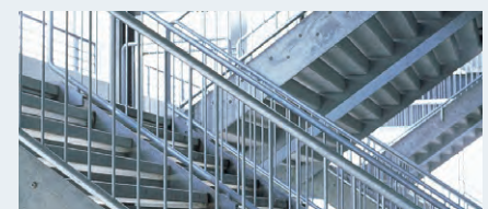
▲溶融亜鉛めっき処理を施した施工例
